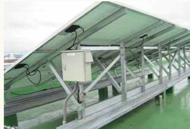
約3kW 3段4列横置20°
